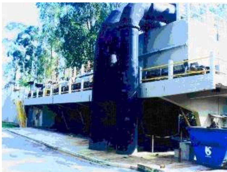
Figura 4.9: Estação de pré-condicionamento de esgotos da SABESP (EPC) do José Menino (Santos), que atende à grande parte dos municípios de Santos e de São Vicente. A EPC está conectada a um sistema de disposição oceânica (emissário submarino) que lança o efluente na região central da Baía de Santos, a aproximadamente 4 km da praia.
